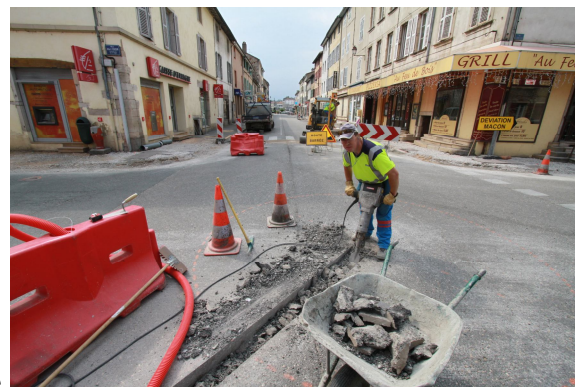
Réalisation du rond-point remplaçant les feux tricolores.
